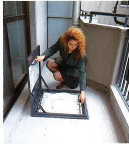
②下蓋を吊り棒を外して開き、袋を降下させます。
